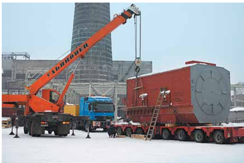
Разгрузка турбогенератора на Новокузнецкой ГТЭС
