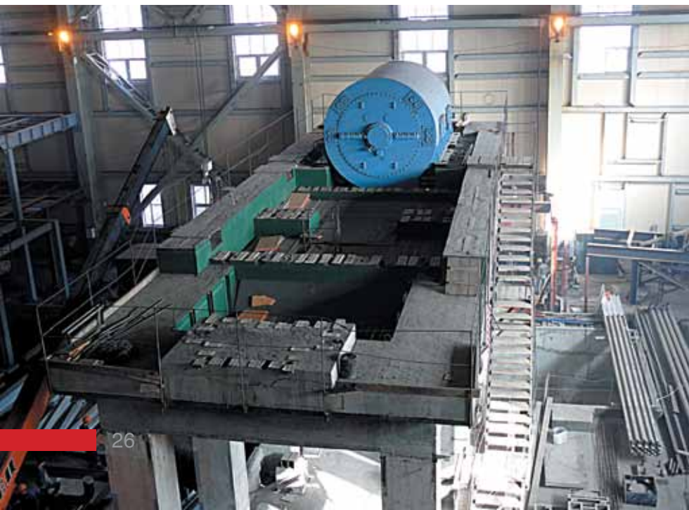
Подготовленный фундамент для турбогенератора №4 на Томь-Усинской ГРЭС
