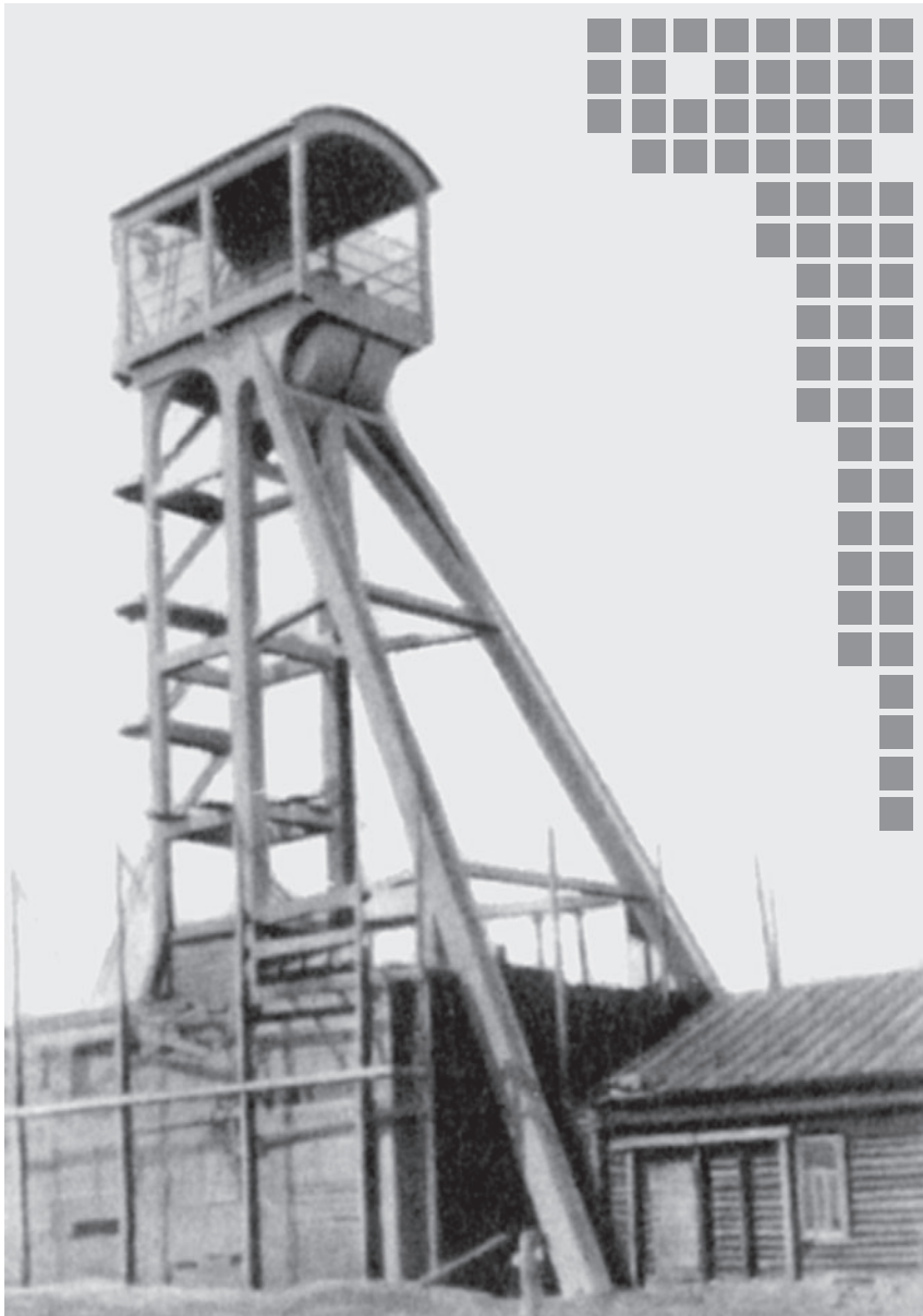
Первый в СССР бетонный копер, шахта №5-7, 1923 г.
