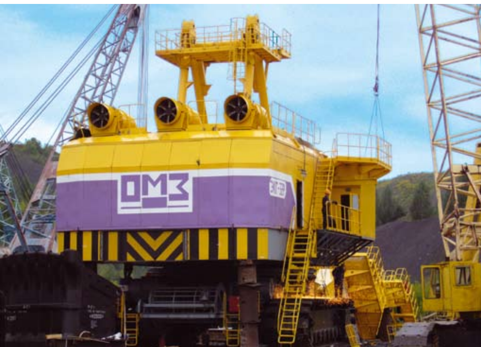
Рис. 3. Монтаж ЭКГ-32Р на Краснобродском разрезе (ОАО «УК «Кузбассразрезуголь»)
